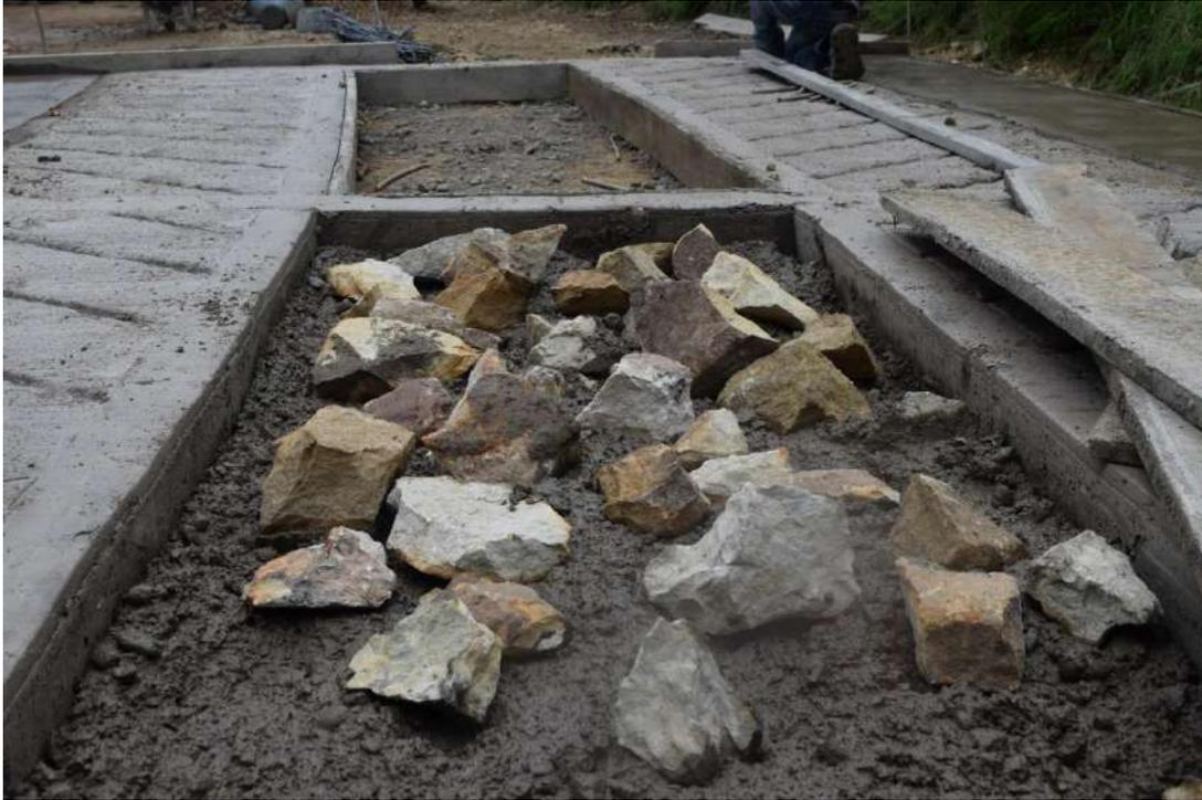
**Detalle de concreto ciclópeo entre las placas de concreto reforzado**
