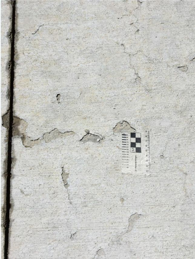
Delaminación por exudación en un pavimento.
