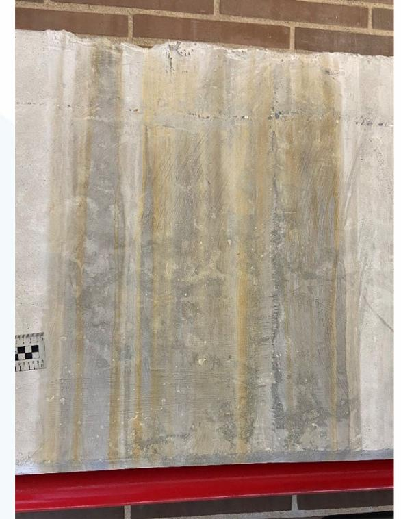
Lesiones por humedad en una viga (color, oxidación)
