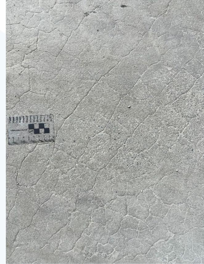
Lesión por abrasión en un pavimento, con amplificación de imperfecciones.
